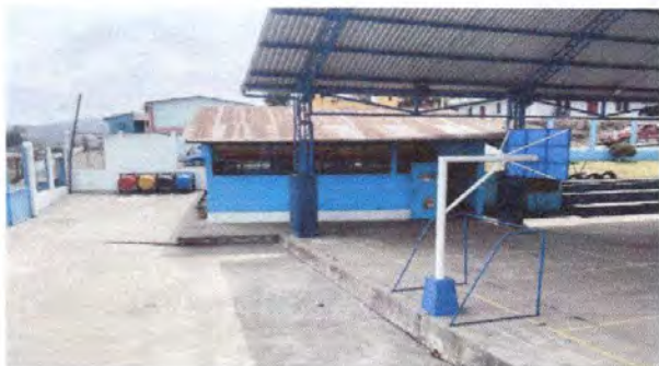
Foto 1: Sustitución de lámina, por lámina troquelada aluzinc modulo 1
