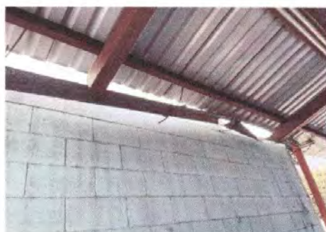
Foto 9: Sustitucion de canal de pvc modulo 5 y 6
