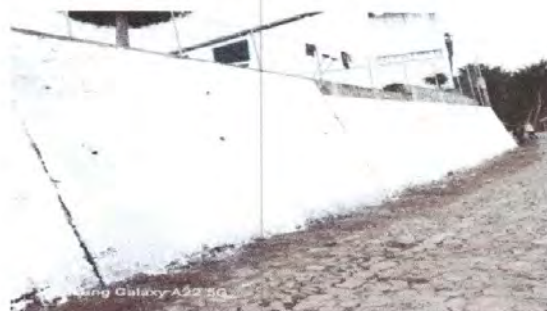
Foto 10: Pintura en muro exteriores e interior
