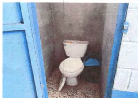
Foto 4: Sustitución inodoro modulo 3 sanitarios
