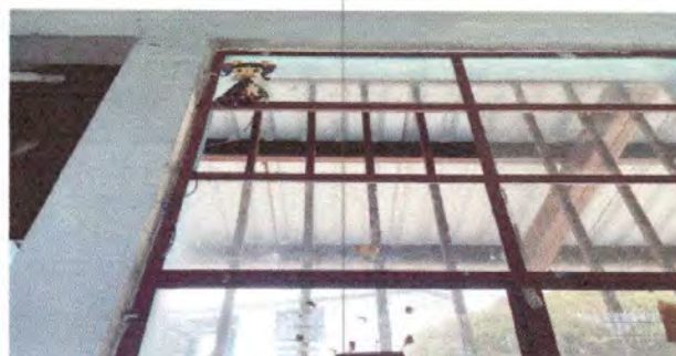
Foto 6: sustitucion de vidrios modulo 1 2 3 4 y 5
