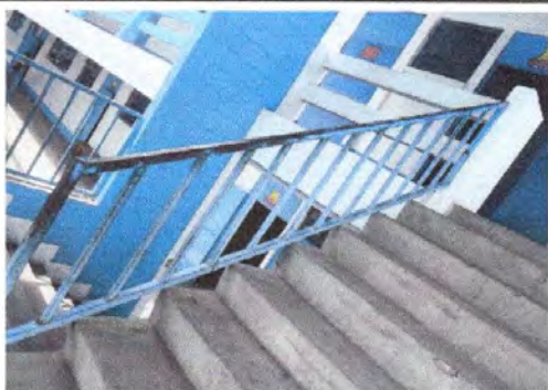
Foto 3: Mantenimiento a barandas de metal modulo 3
