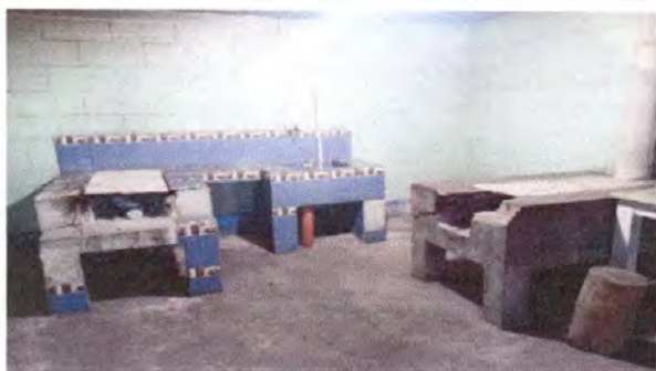
Foto 7: Sustitución de estufa rural completa + Sustitución de chimenea de concreto + Instalación de azulejo en estufa rural + Sustitución de lavatrastos modulo 6
