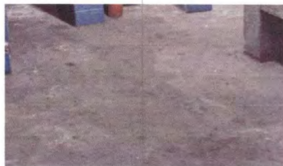
Foto 8: Sustitución de piso torta de concreto por piso cerámico modulo 6
